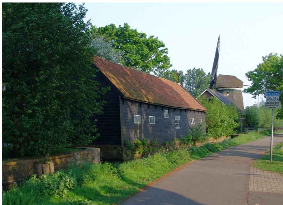
Edam Zuidpolder. Het gebouw van het stoomgemaal staat links van deze schuur.
